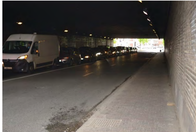
Figure 229 : Traversée au niveau de la Rue des Vétérinaires (ARIES, 2018)
