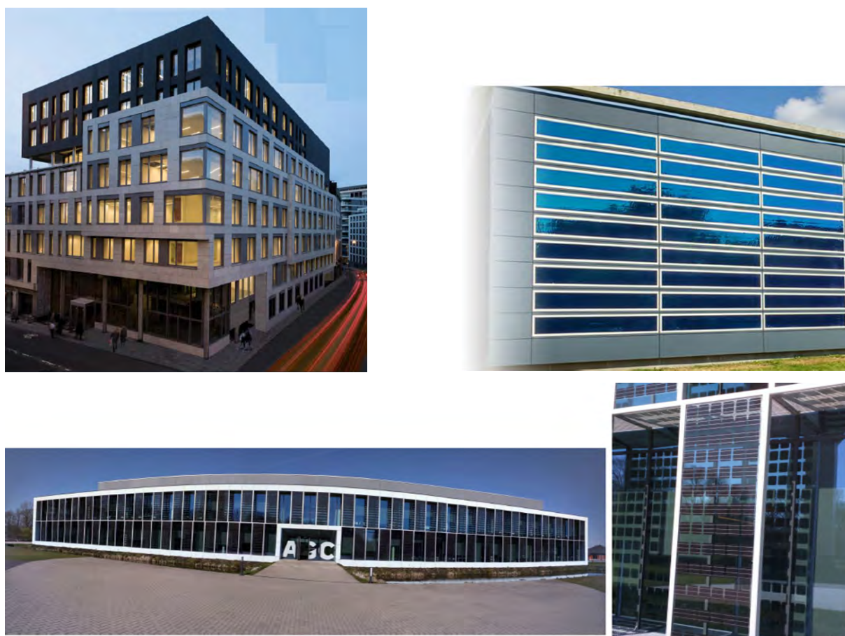
Figure 362: Panneaux photovoltaïques en façade (BIPV) (Source : Archiexpo.fr)
