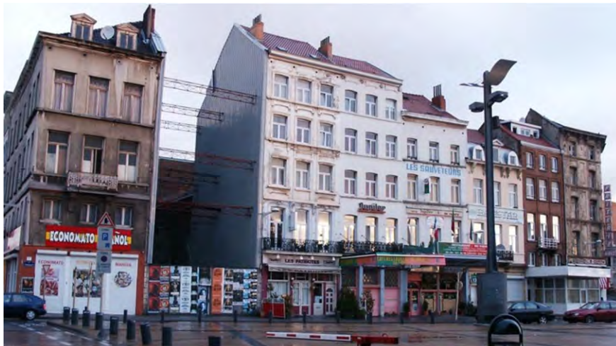
Figure 28 : Maisons néoclassiques sur l'îlot Jamar Argonne, longeant l'Esplanade de l'Europe (DPC, 2015)
