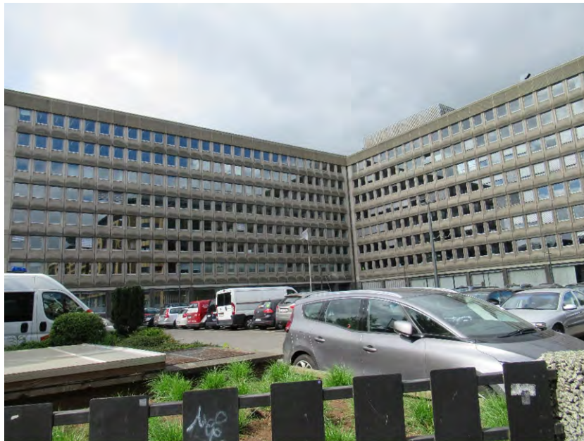
Figure 36 : Vue de l'angle nord-est de l'îlot France Bara (ARIES, 2018)
