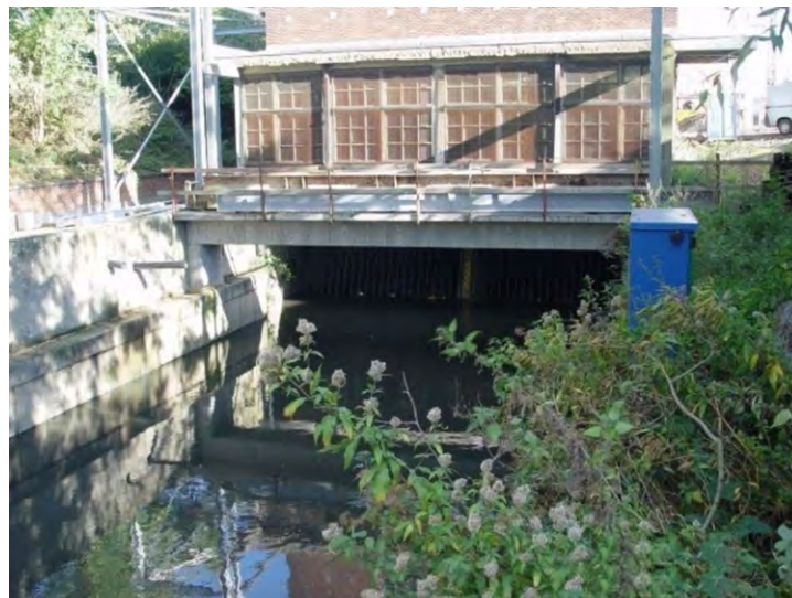
Figure 193 : Photographie de l'entrée de la Senne dans le pertuis (Flowbru, 2018)
