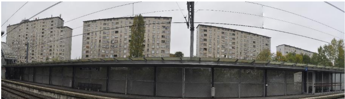
Photo 48 : Immeubles hauts situés à l'ouest de la friche (Photo : ABO)
