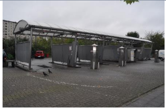
Photo 51 : Carwash (Photo : ABO)
