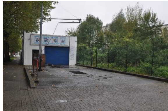
Photo 63 : Carwash (Photo : ABO)
