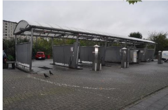
Photo 56 : Carwash (Photo : ABO)
