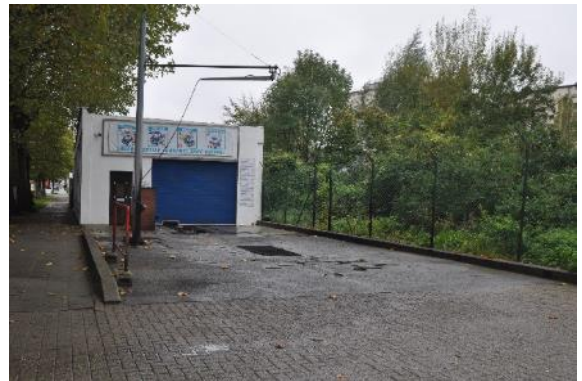
Photo 53 : Carwash (Photo : ABO)
