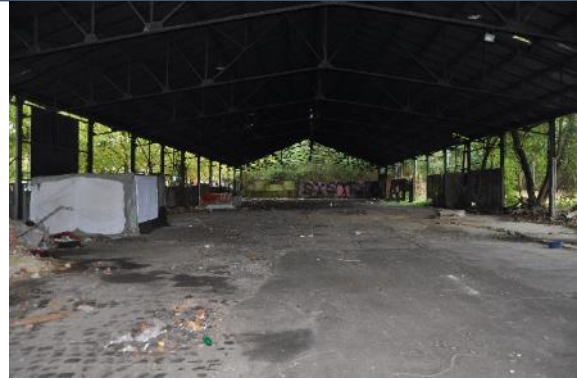
Photo 26 : Halle aux charbons (Photo : ABO)
