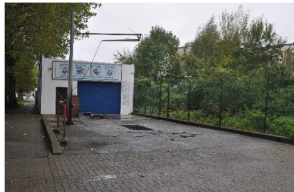
Photo 24 : Carwash (Photo : ABO)
