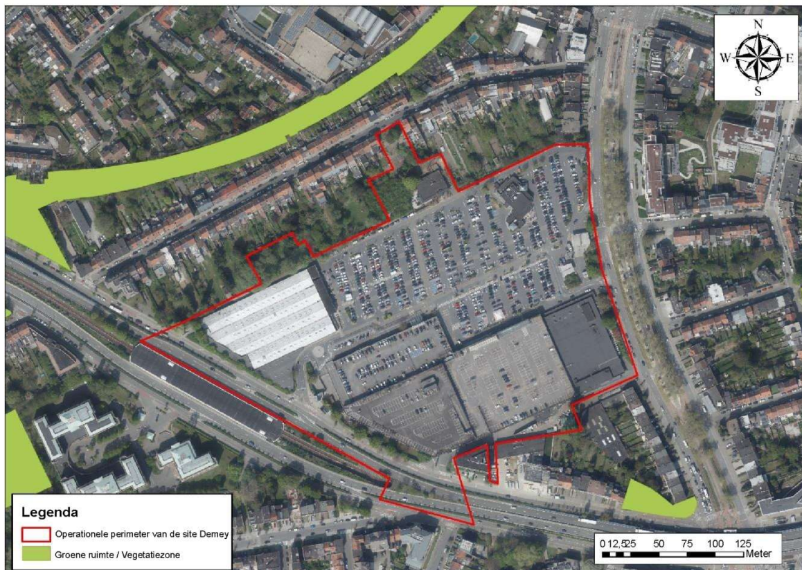
Afbeelding 1131: Openbaar toegankelijke groene ruimtes rond de operationele perimeter van de site Demey (ARIES op Brugis-achtergrond, orthofotoplan 2017)
