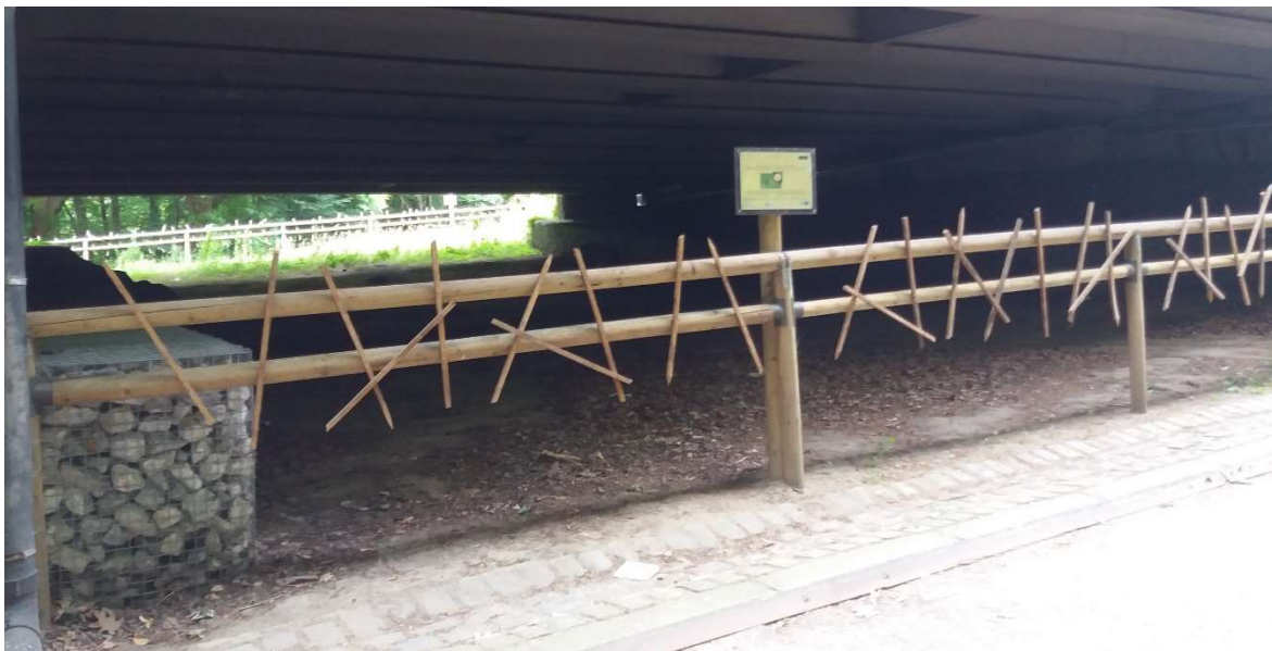
Afbeelding 911: Zicht op de doorgang met bestaande fauna onder het viaduct van Dry Borren (ARIES, 2018)
