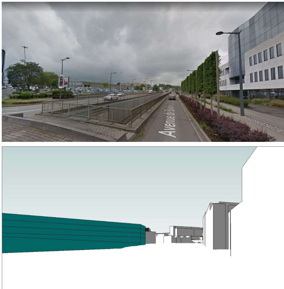
Afbeelding 509: Uitzicht vanaf de Jules Cockxstraat, in bestaande situatie (bovenaan) en in het trendscenario (onderaan) (Google Street View & ORG 2 , 2018)
