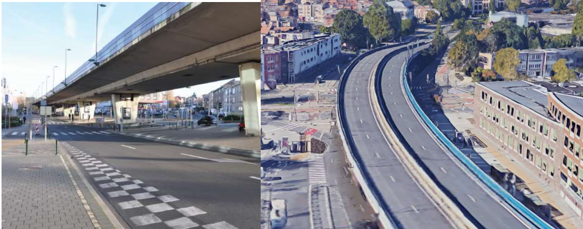
Afbeelding 620: Viaduct in de bestaande toestand (ORG 2 , 2019; Google Maps, 2019)
