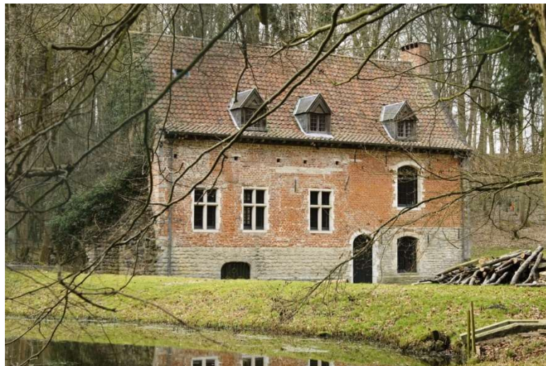
Figure 464 : Château forestier des Trois Fontaines (Brugis)
