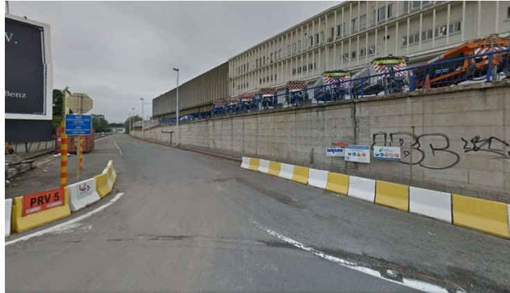
Figure 392 : Vue de l'accès actuel au site Triangle (Google Streetview, 2014)
