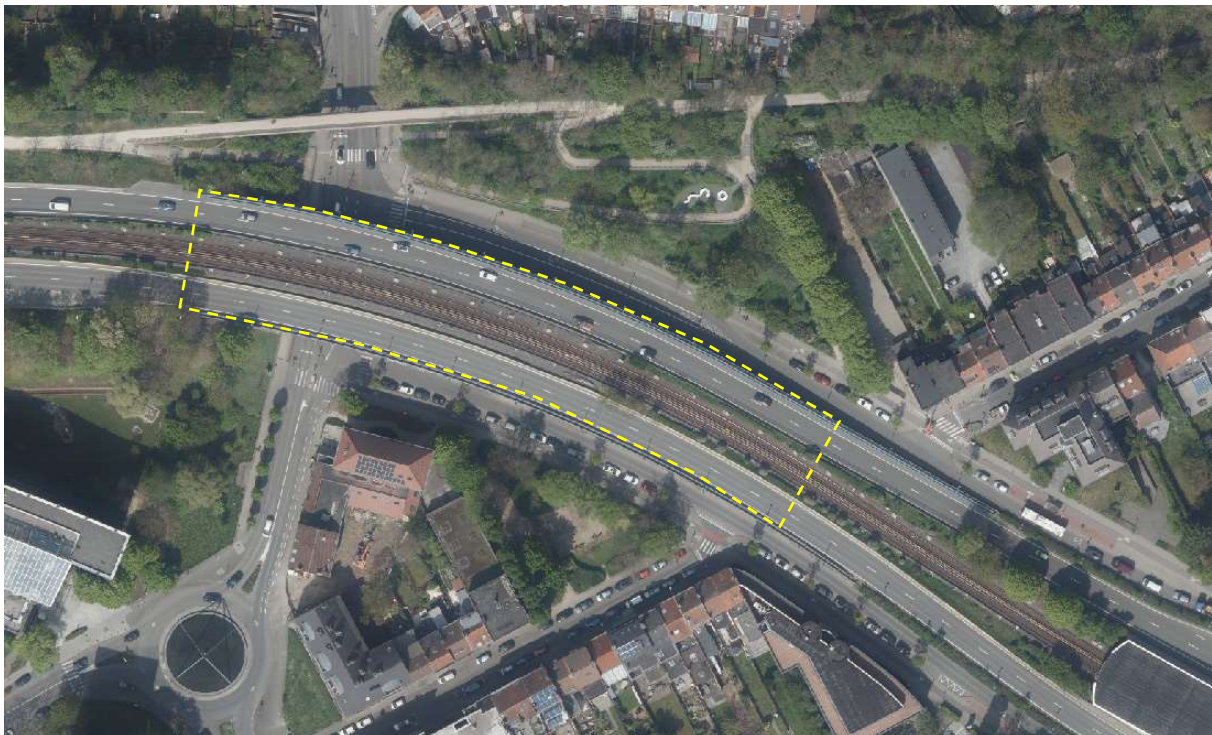
Figure 304 : Localisation du viaduc de la chaussée de Watermael (Brugis, 2018)
