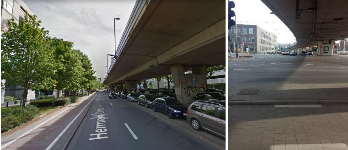
Figure 303: Ombre sur l'espace public du côté nord du viaduc Herrmann-Debroux (à gauche : Google Street View, mai 2017 ; à droite : Antea, février 2018)
