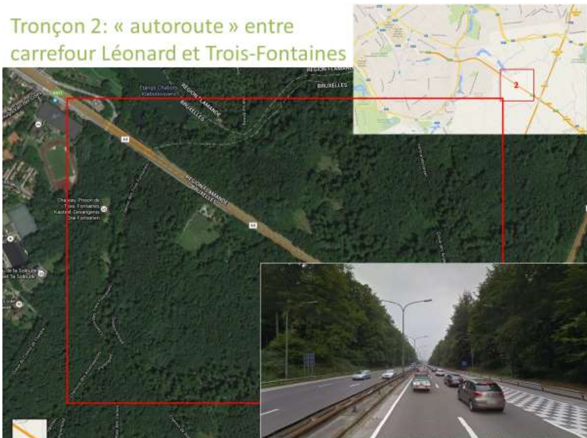
Figure 207 : Illustration du tronçon Léonard – Trois Fontaines (Google Maps, 2018)
