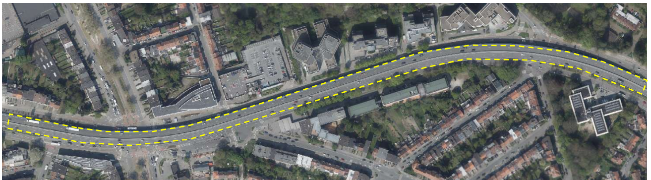
Figure 302 : Localisation du viaduc Herrmann-Debroux (Brugis, 2018)
