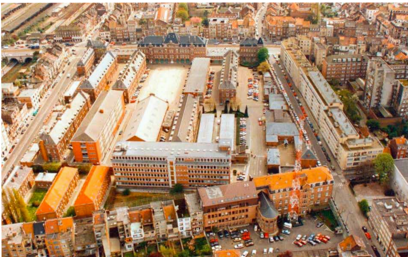
Bron: BUUR - luchtfoto van de site vanuit het noordwesten.
