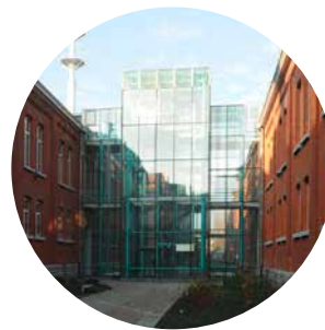
1980-2015 GEBOUW F en G
