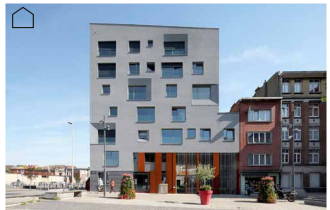
↑ Projet mixte rue de Liverpool (photo ©B612associates)
