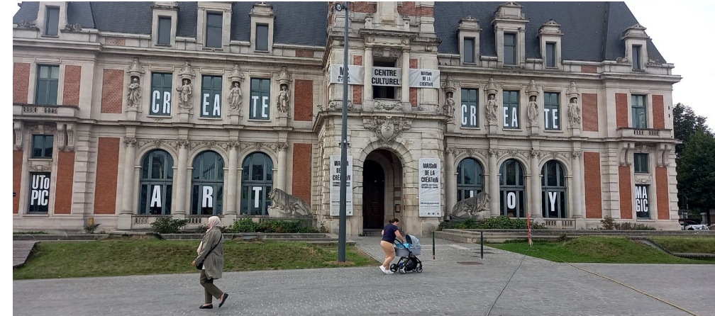
Renovatie van het Bockstaelplein
