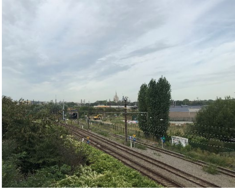
Site Schaarbeek-Vorming, Brussel
