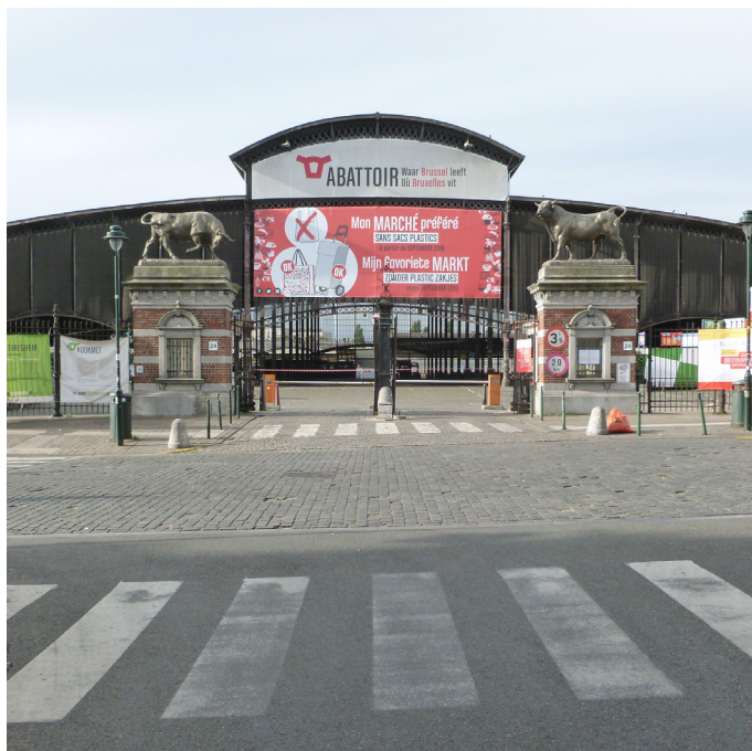
- photo de la situation existante -
