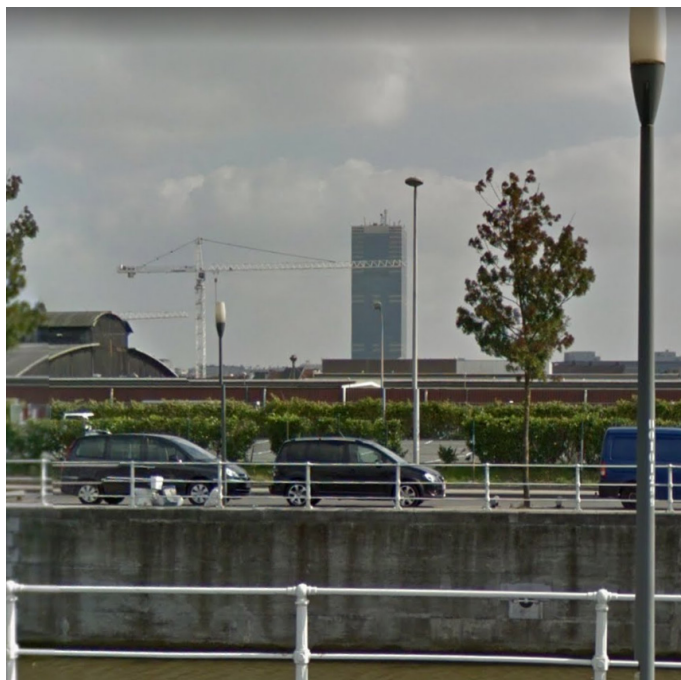
- photo de la situation existante -
