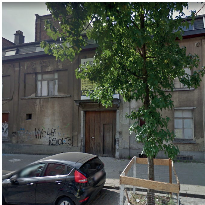
- photo de la situation existante -
