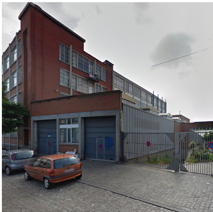
- photo de la situation existante -
