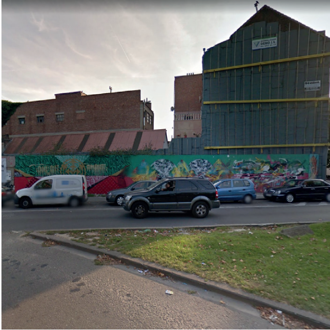
- photo de la situation existante -
