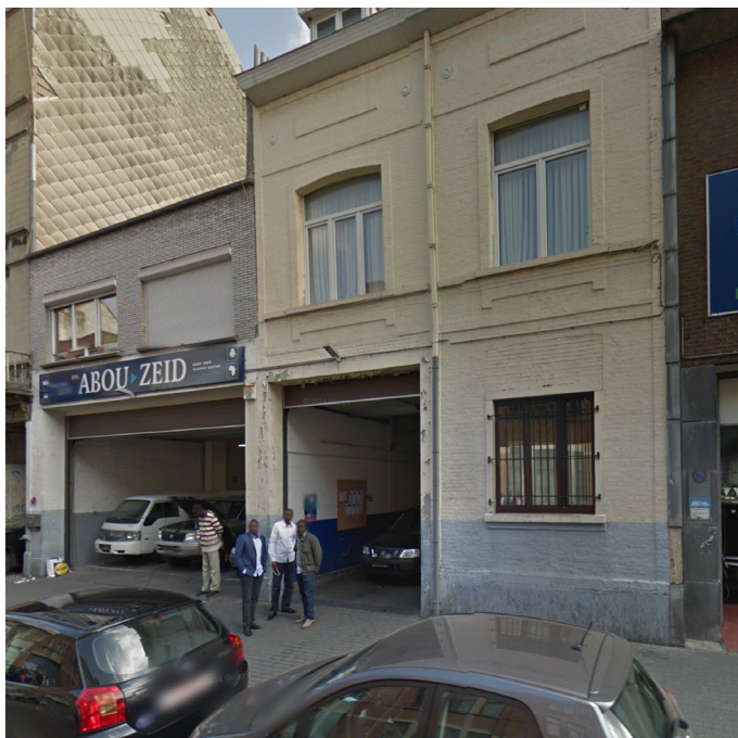
- photo de la situation existante -
