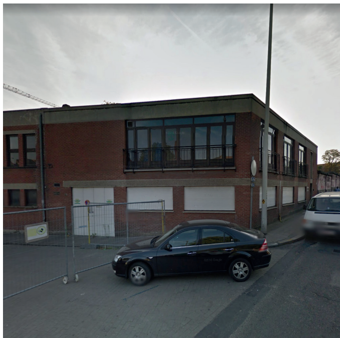
- photo de la situation existante -
