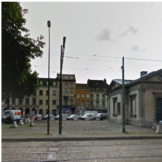
- photo de la situation existante -
