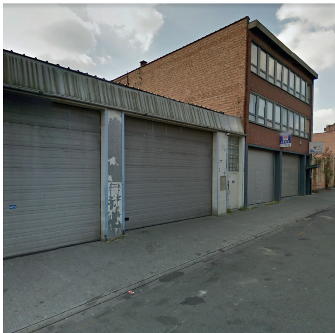
- photo de la situation existante -
