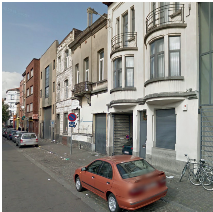
- photo de la situation existante -
