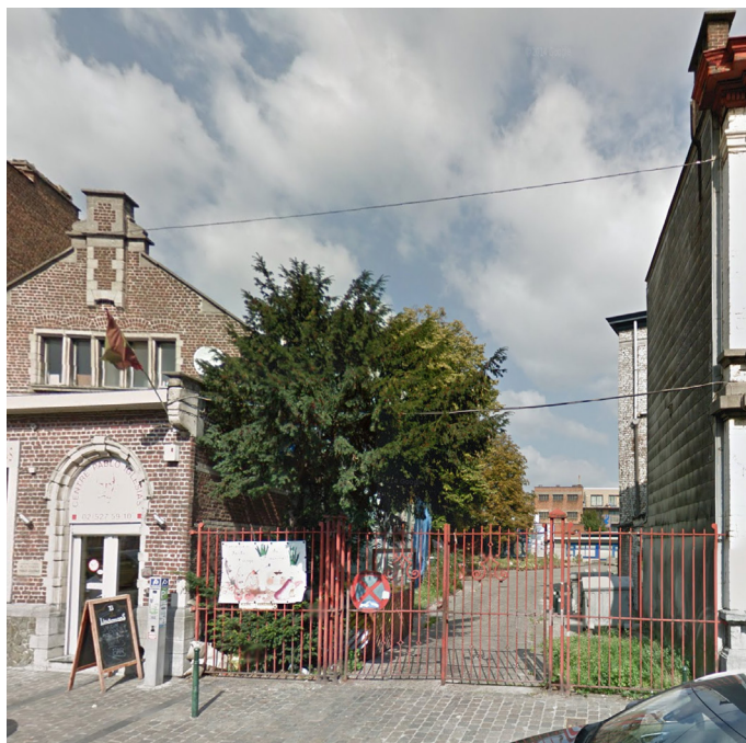
- photo de la situation existante -
