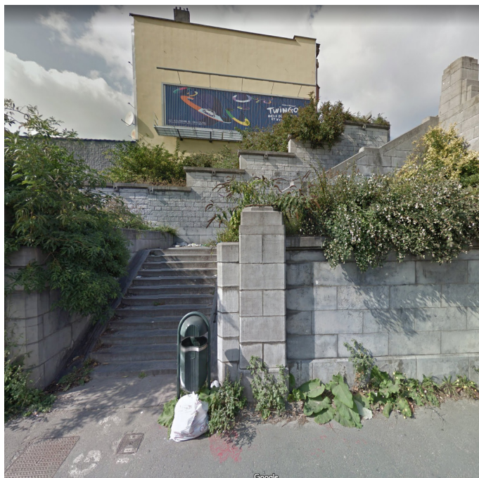
- photo de la situation existante -
