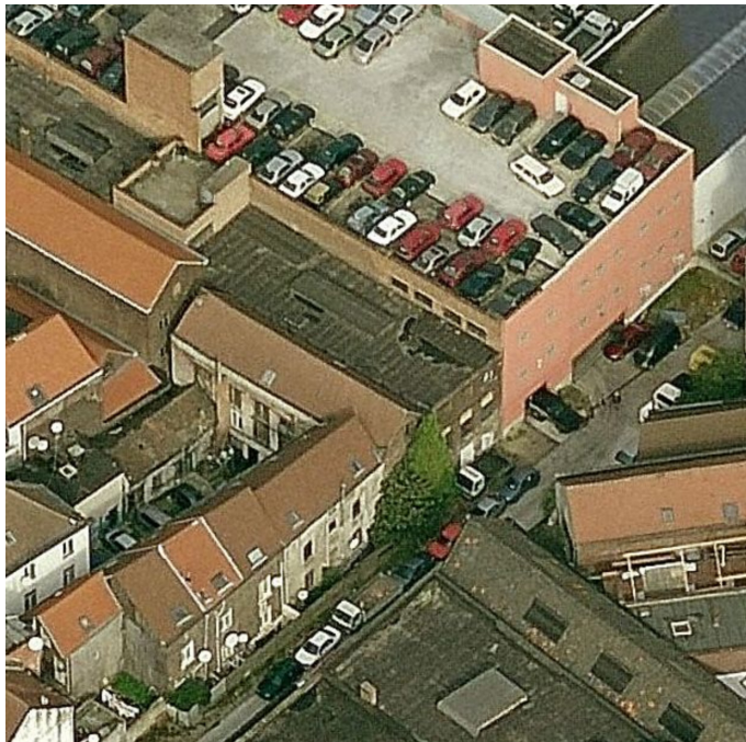
- photo de la situation existante -
