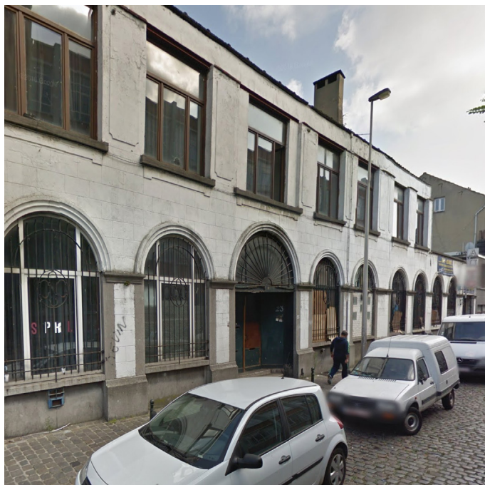
- photo de la situation existante -
