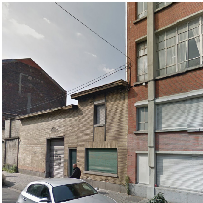
- photo de la situation existante -
