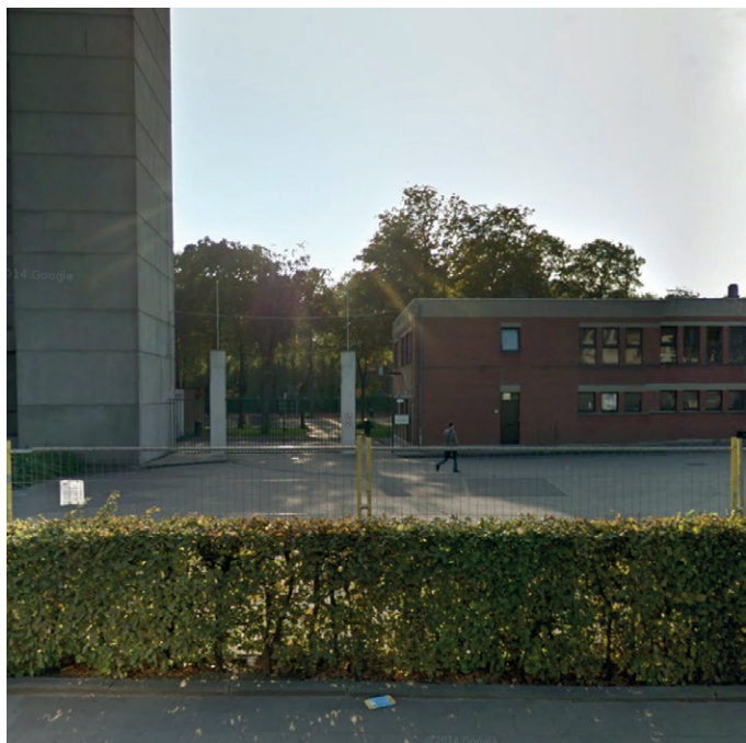
- photo de la situation existante -
