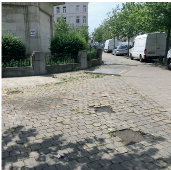
- photo de la situation existante -
