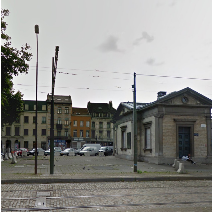
- photo de la situation existante -
