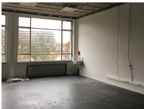
↑ Renovatie klaslokaal / Salle de classe en rénovation
