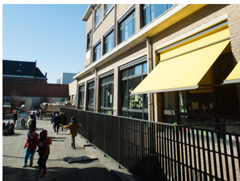
↑ Schoolplein en zuidgevel / Cour de récréation et façade Sud
