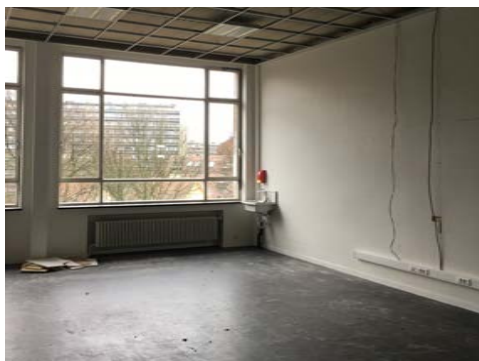
↑ Renovatie klaslokaal Salle de classe en rénovation
