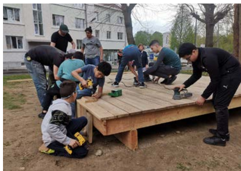
↑ Meubelmakerij, VZW Fabrik Atelier de construction de mobilier, ASBL Fabrik
