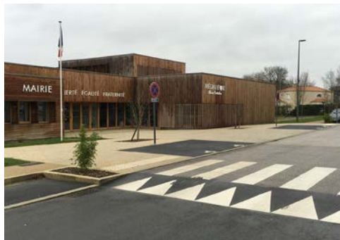
↑ Het verhogen van de weg om het verkeer te vertragen Surélévation de la voirie pour ralentissement
