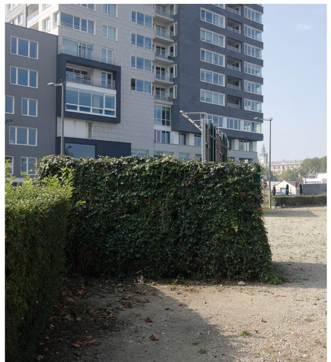
la sous-station électrique
