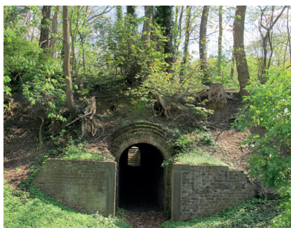
↑ Tunnel et tranchée du tir national
