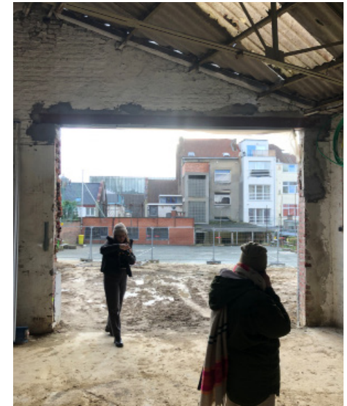
↑ Vue du hangar vers la cour Zicht vanuit de schuur op het speelplaats
