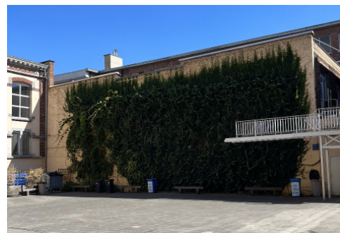
↑ Le mur existant / bestaande muur;
