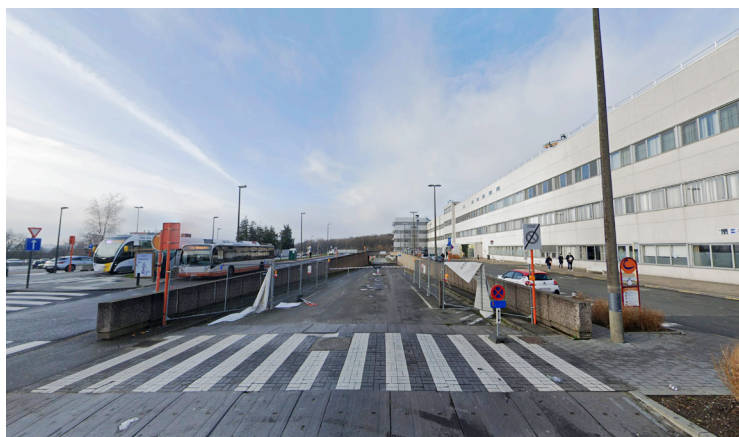
Afb. 33 Tunnel aan de spoedafdeling van het UZ
