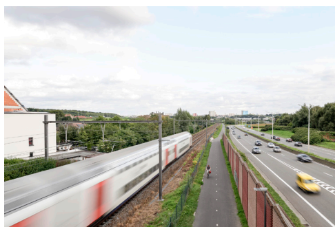
Afb. 1 Bundel van bypass infrastructuur
