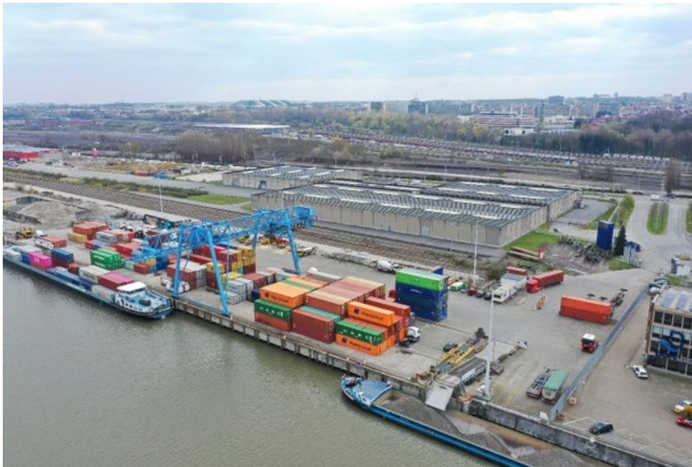
FIGUUR 29 : LUCHTFOTO VAN DE HAVENTERMINAL
