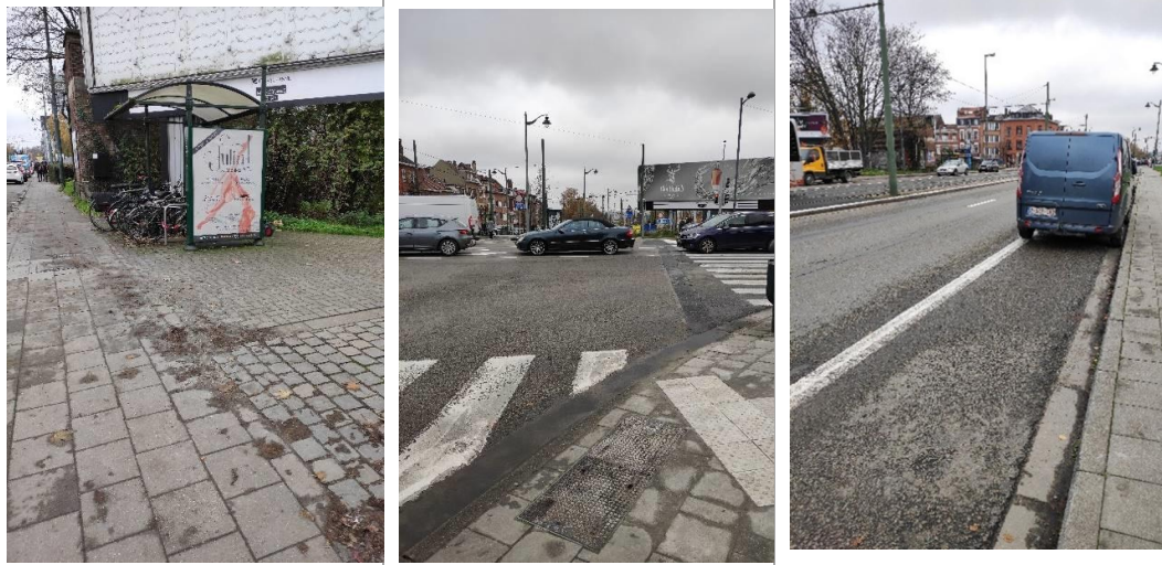
FIGURE 5-60 PHOTOS DE L'INFRASTRUCTURE AVENUE JULES BORDET-HOUTWEGS, TRAFIC LENT
