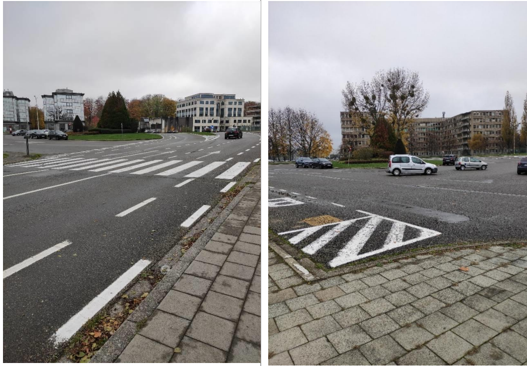
FIGURE 5-70 PHOTO DE L'INFRASTRUCTURE RUE D'EVERE , TRAFIC MOTORISÉ
