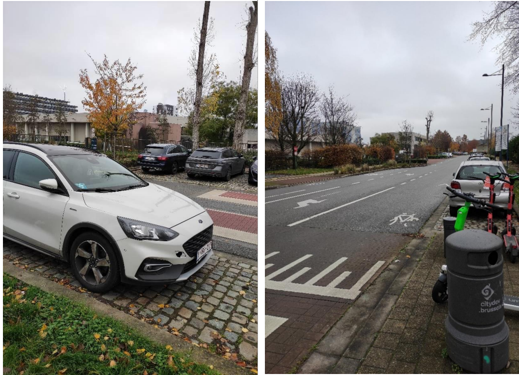
FIGURE 5-67 PHOTOS DE L'INFRASTRUCTURE RUE DE SCHIPHOL, TRAFIC MOTORISÉ
