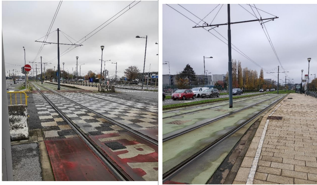
FIGURE 5-58 PHOTOS DE L'INFRASTRUCTURE AVENUE LÉOPOLD II, TRANSPORTS PUBLICS
