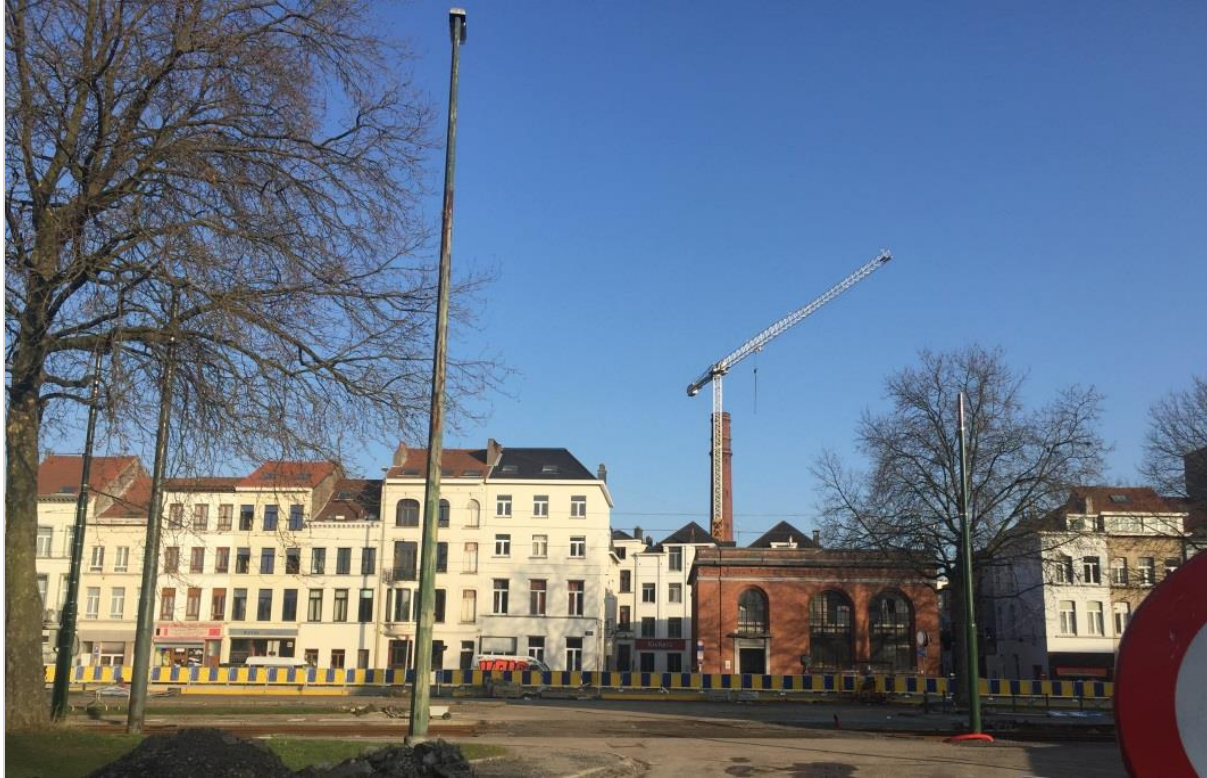
Photo 1 : Vue sur le secteur de la tour Brunfaut - (Source : Agora février 2017)
