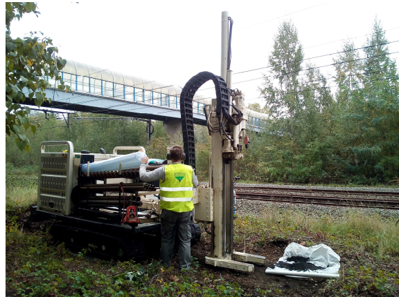
Figuur 60: Uitvoering van mechanische boringen met behulp van een Geoprobe
