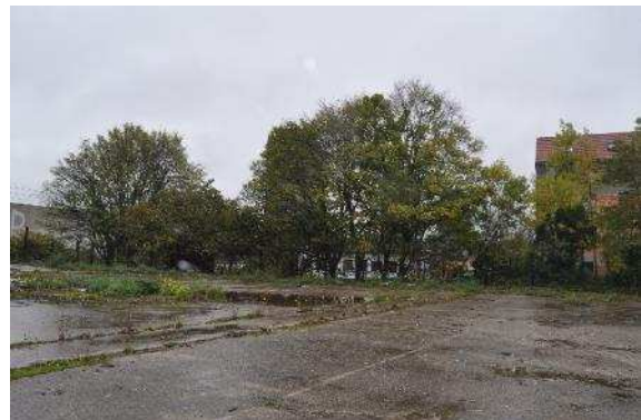
Foto 10: Betonnen zone met plasvorming van regenwater, in het noorden van de site (Foto: ABO)
