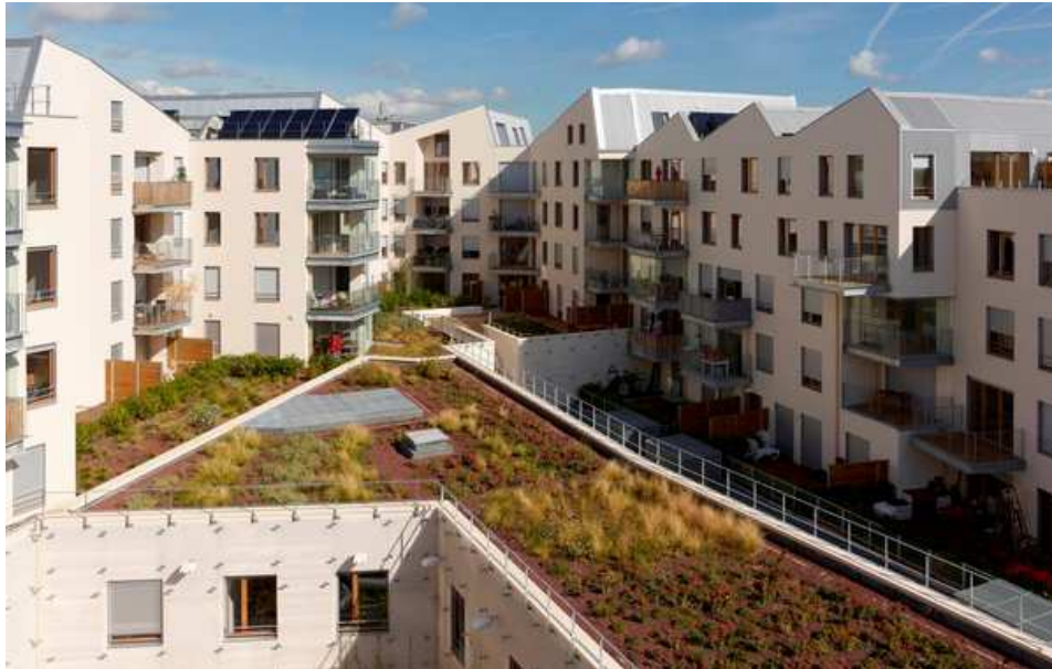
Figuur 150: Îlot Armagnac Island in Bordeaux (ANMA-project): 163 sociale woningen en koopwoningen met een gemiddelde grondinname-coëfficiënt van 3,3 (Bron foto: website bureau ANMA, foto S. Chalmeau)
