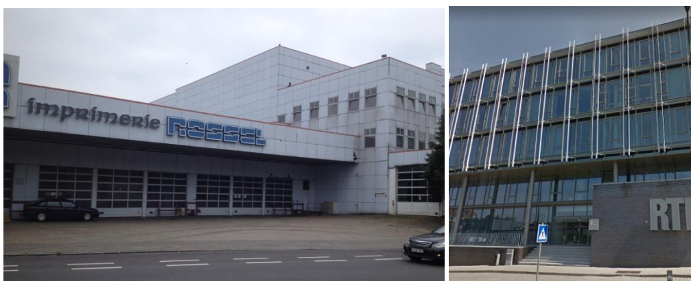
Quartier ZEMU (imprimeries Rossel cédées pour une opération de logements, nouveau siège de RTL)
