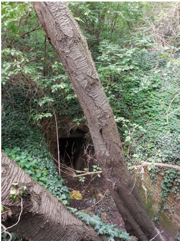
Vue sur une tranchée en pied de talus
