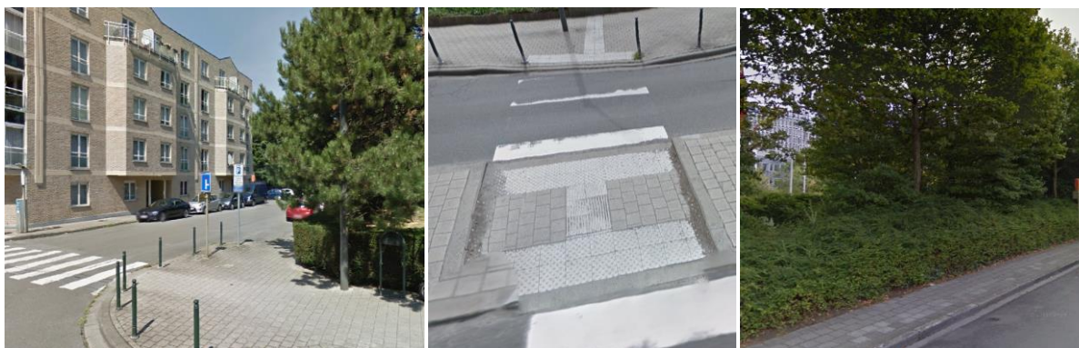
Avenue Colonel Bourg et Contre-allée au boulevard Reyers – trottoirs larges, revêtement continu et en bon état, présence de potelets pour la sécurisation des piétons au carrefour, dalles podotactiles
