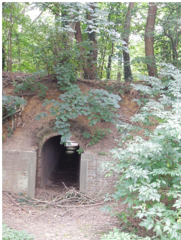
Vue sur un passage vouté
