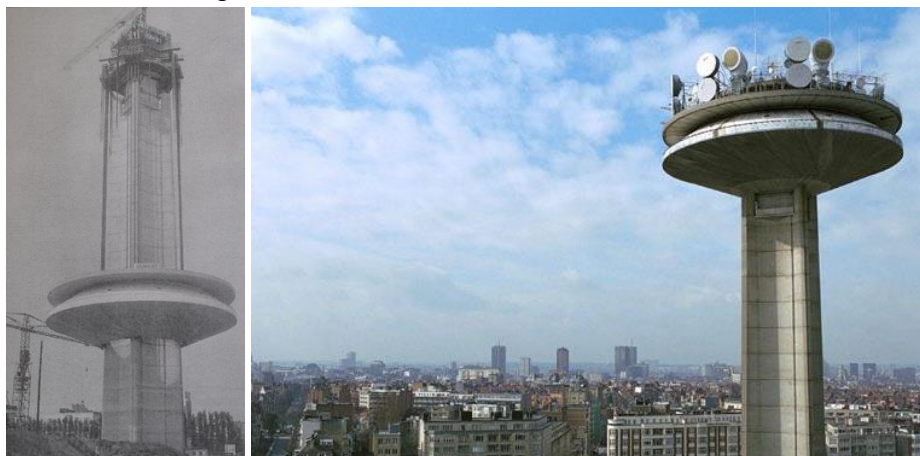
Tour de télécommunication
