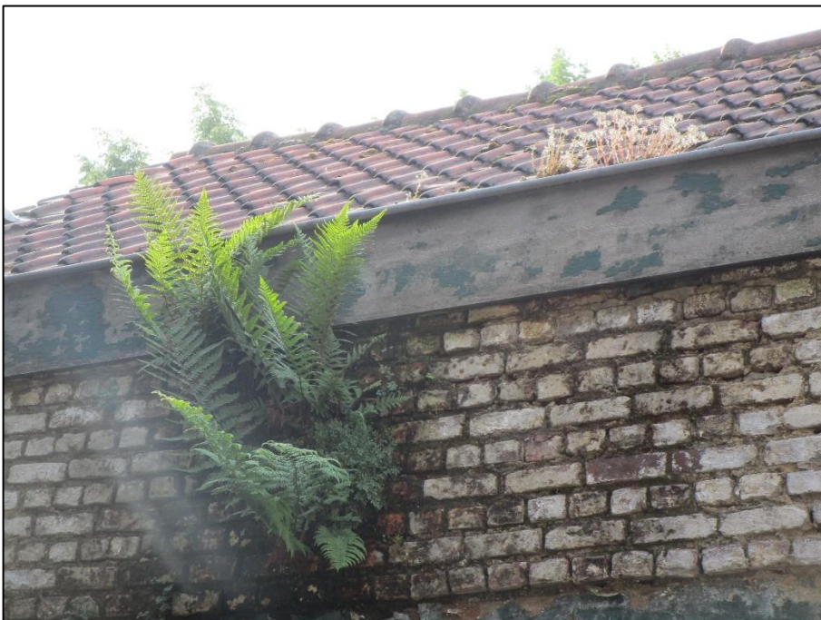
Figuur 6-12: Muurvegetatie vormt een speciale flora op de oude muren en daken
