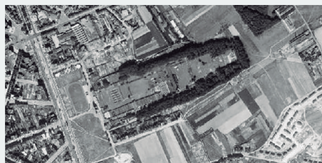
Photo aérienne, Tir National : 1950.
