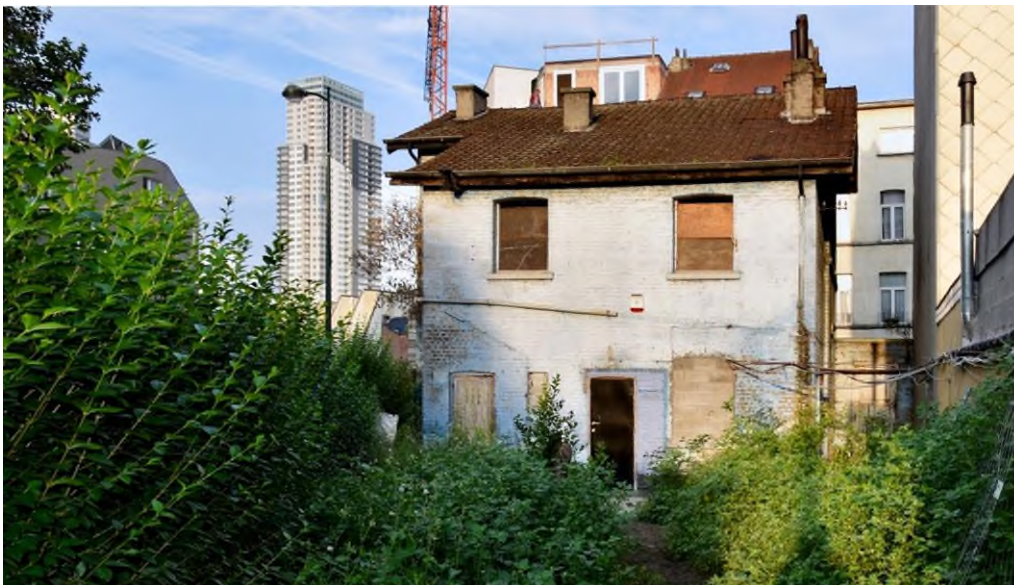
Figure 28 : Vue arrière de l'ancienne maison du garde-barrière (URBAN – DPC, 2016)
