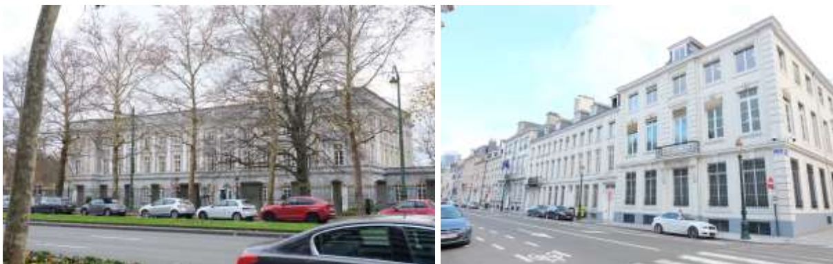
Figuur 87: Paleis der Academiën (links) en bouwwerken langs de Hertogstraat (rechts) (ARIES, 2018)
