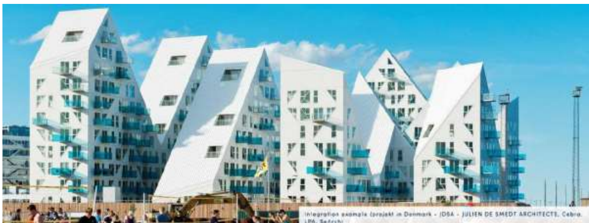
Figuur 228: Fotovoltaïsche panelen in gevels (BIPV) (voorbeelden)
