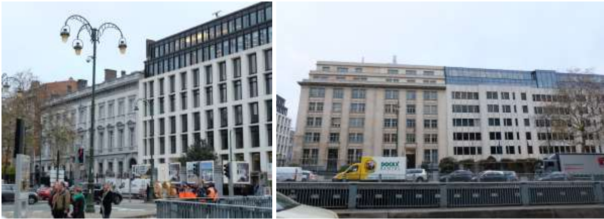
Figuur 88: Gebouwen langs de Kunstlaan aan de kant van de Koningswijk (ARIES, 2018)
