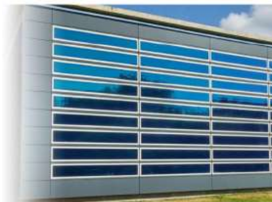
Figuur 226: Fotovoltaïsche panelen in gevels (BIPV) (voorbeelden)
