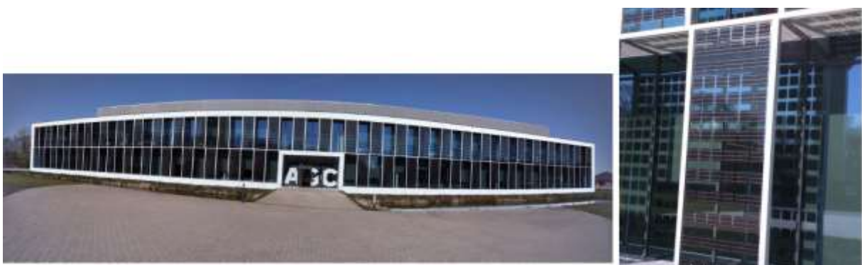
Figuur 227: Fotovoltaïsche panelen in gevels (BIPV) (voorbeelden)
