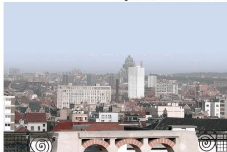
9B - Vue après augmentation de la hauteur de la tour Brunfaut de 5 étages
