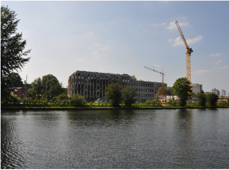
Vijvers in park Malou met reconversie van kantoren op de achtergrond
