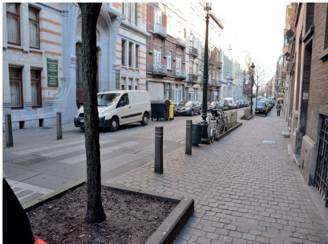
RUE JOSAPHAT, AMÉNAGEMENTS DEVANT L'ENTRÉE DE L'ÉCOLE 1 JOSAPHATSTRAAT, INRICHTING VOOR INGANG ÉCOLE 1
