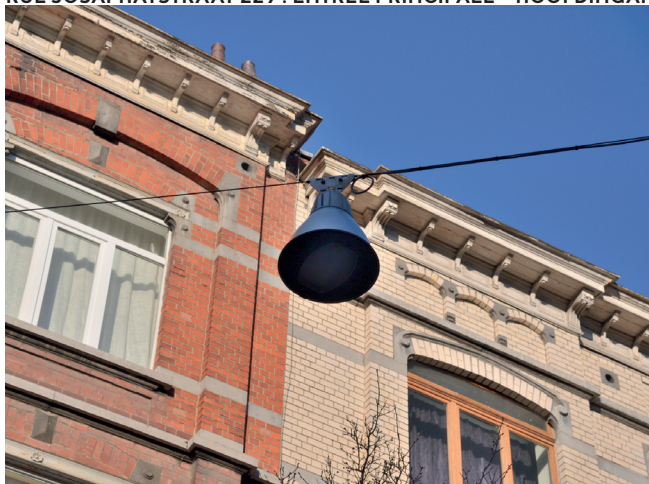
RUE JOSAPHAT, LUMINAIRES SUSPENDUS JOSAPHATSTRAAT - HANGLAMPEN
