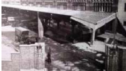
Foto. Betonnen luifel- Photo Auvent en béton
