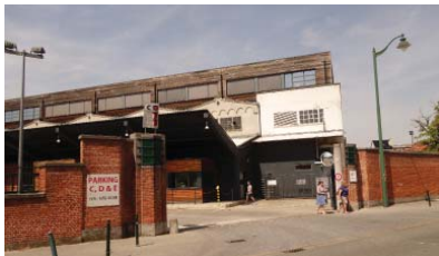
Foto. De muur- Photo Le mur
