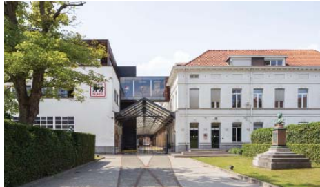
Fig. Foto Directiegebouw - Photo Bâtiment de la direction
