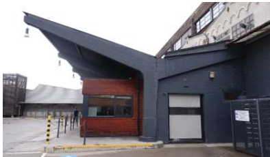
Foto. Betonnen luifel- Photo Auvent en béton
