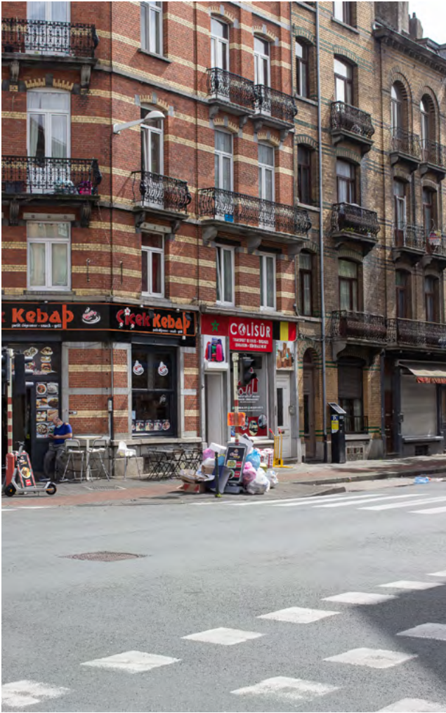
Dépôt sauvage, carrefour de la rue Bara et de la rue des Vétérinaires.
