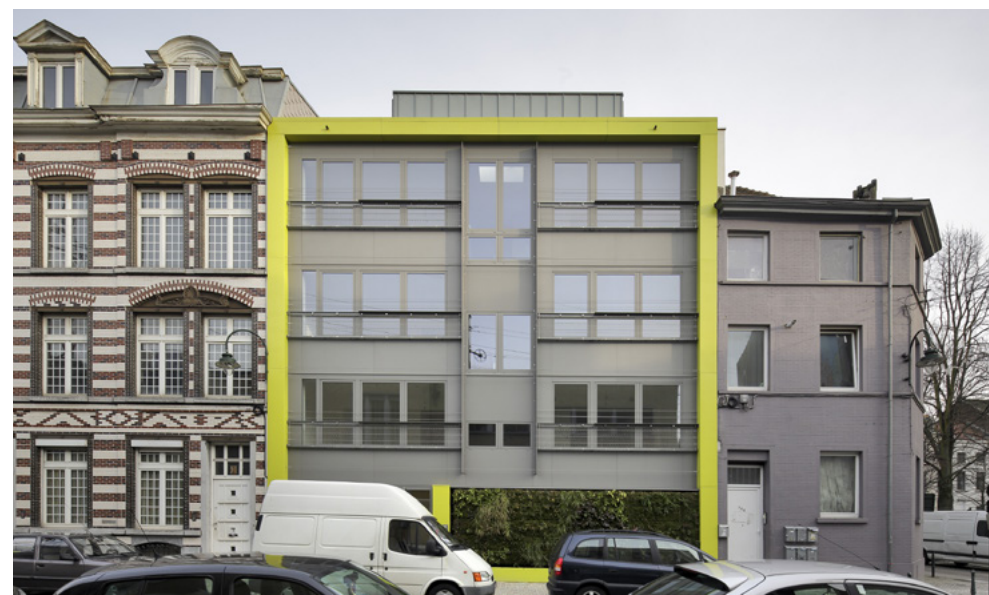
'Nieuwland'. Bouw van 6 lage-energie woningen die een gat in de bouwlijn opvullen. Wijkcontract Rouppe in Brussel-stad © Georges De Kinder
