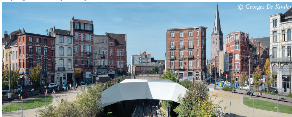
Loopbrug Verboekhovenplein - Wijkcontract Navez-Portaels te Schaarbeek
