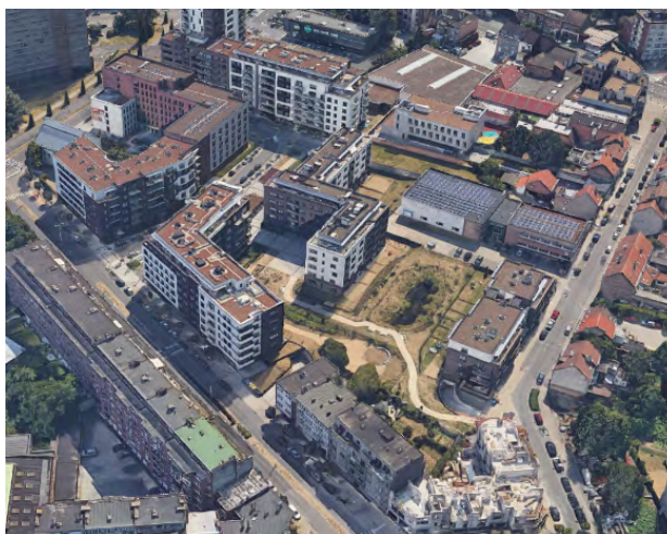
Armonea, Twee Huizenstraat, appartementsgebouwen + medisch centrum en rusthuis,
