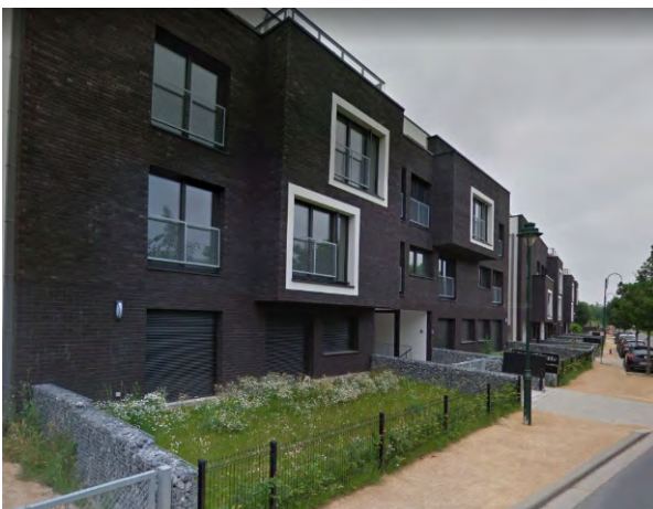
Rue des Jardins des potagers, Haren, FDL, immeubles à appartements, 56 logements
