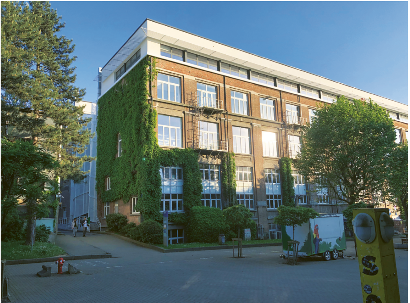
↑ Photo 13 Ajout d'un étage supplémentaire dans un bâtiment de l'ULB sur le campus du Solbosch, Ixelles (mai 2024) Foto 13 Toevoeging van een extra verdieping op een gebouw van de ULB op de Solboschcampus, Elsene (mei 2024)
