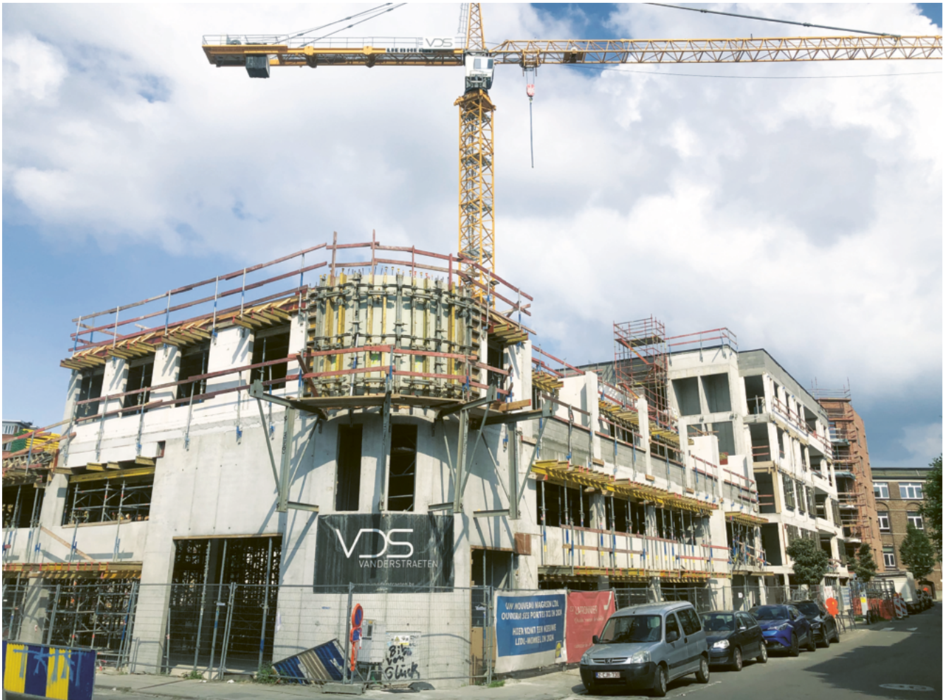
↑ Photo 4 Construction d'un commerce au RDC d'un bâtiment de logement, rue Capronnier, Schaerbeek (mai 2024) Foto 4 Bouw van een winkel op de benedenverdieping van een woongebouw, Capronnierstraat, Schaarbeek (mei 2024)
