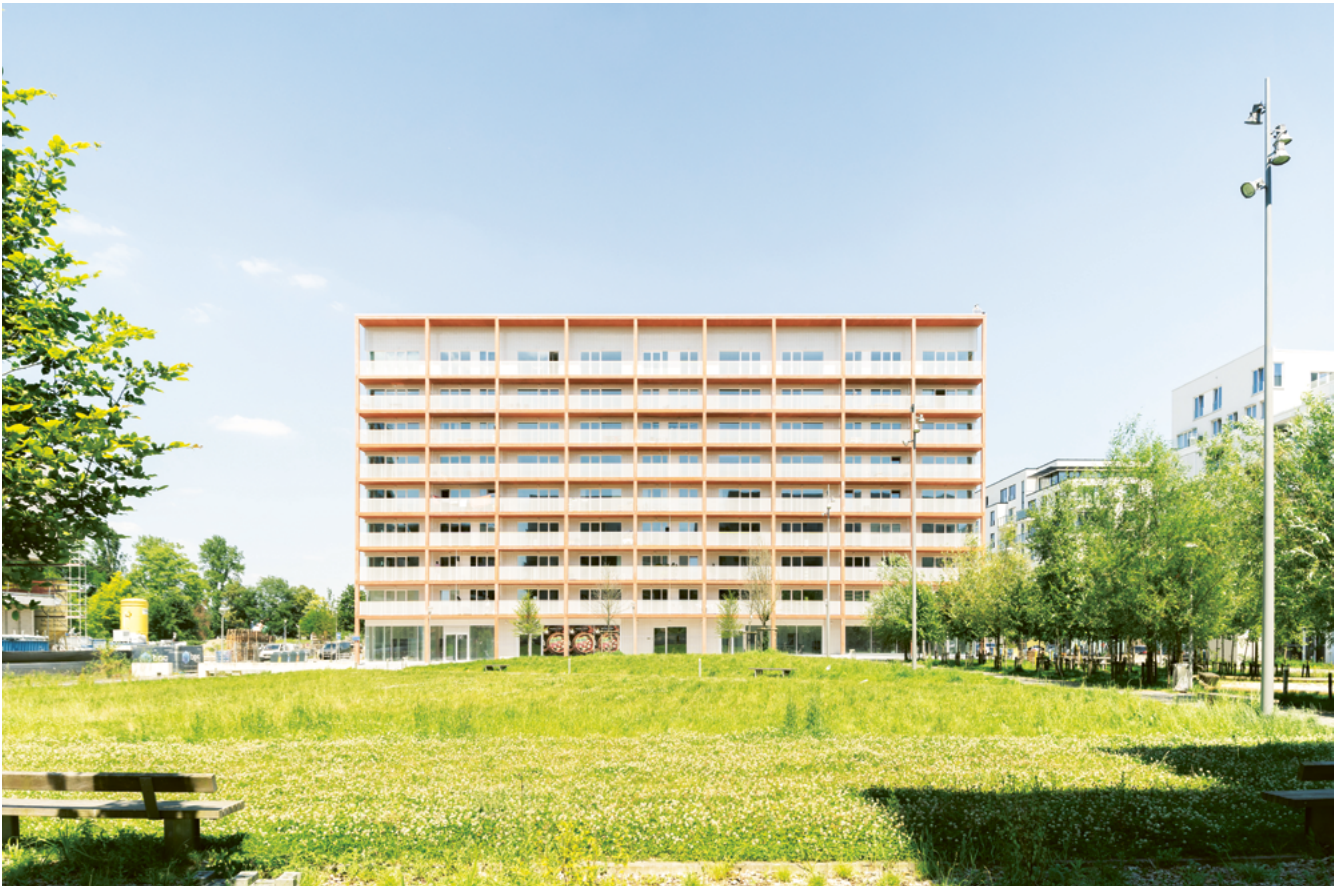
↑ Photo 14 Création de logement en ZEMU rue de la petite île, Anderlecht (juillet 2024)
