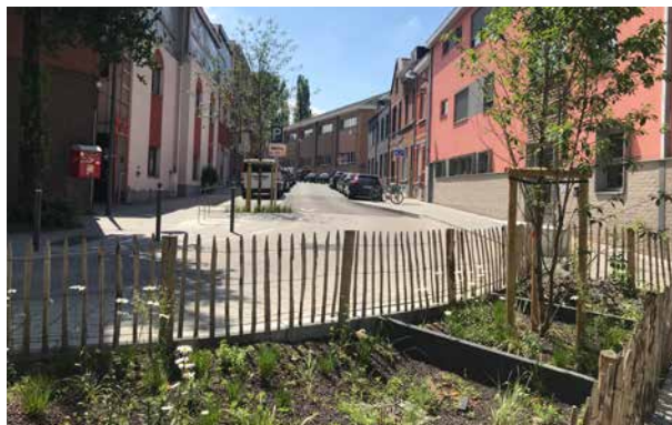
↑ Een wadi scheidt de rijweg van het trottoir en vangt het afvloeingswater op in de Esseghestraat in Jette. © Suède36
