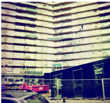
chantier restaurant social /werf sociaal restaurant
