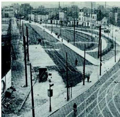
Aménagement du Square Albert 1 (1951)
