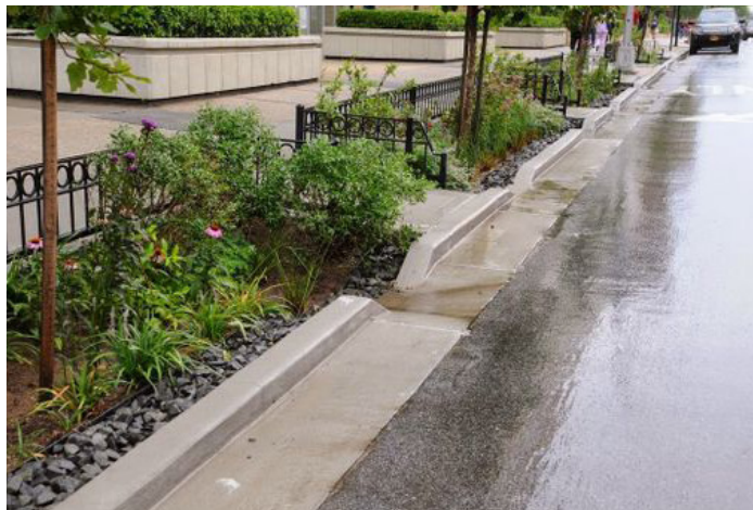
Infiltration d'eau Waterinfiltratie
