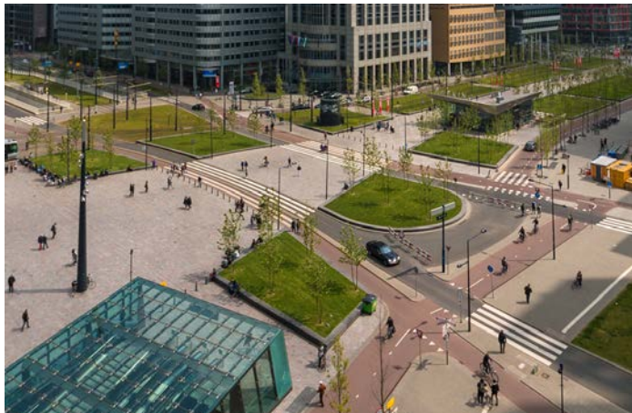
Passage piéton, Gare de Rotterdam Oversteekplaats Stationsplein Rotterdam.
