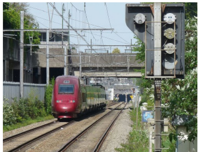
Ligne ferroviaire L28, 2020 Spoorlijn L28, 2020
