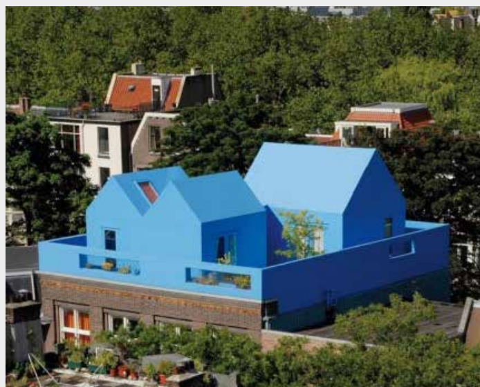
Construire sur l'existant
