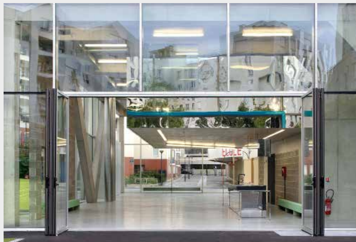
Un rez de chaussée public ouvert sur l'espace public. Référence: Centre culturel et sportif, Bruther, Paris, XXe
