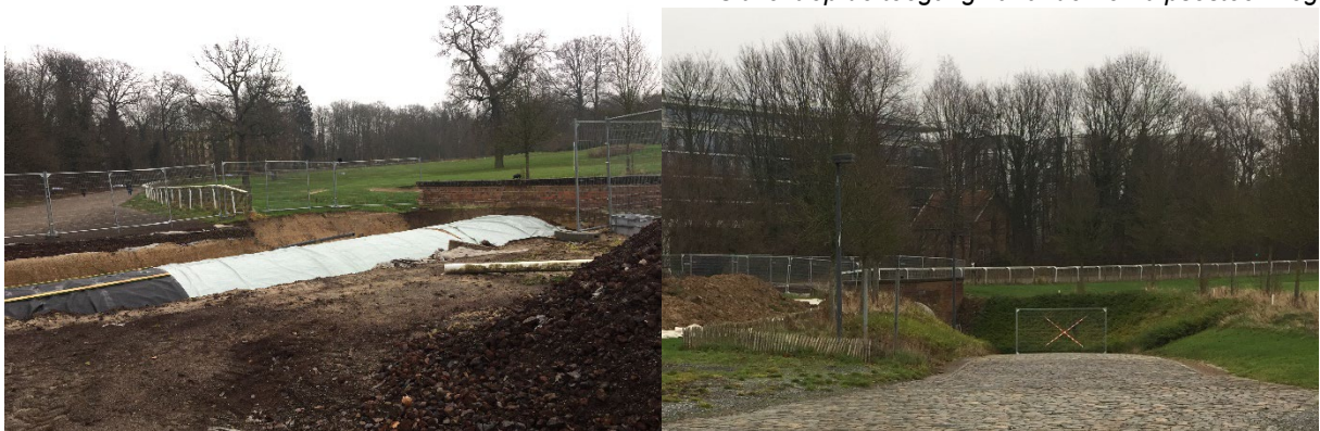
Zicht op de tunnel in herstelling en zicht vanaf het golfterrein
