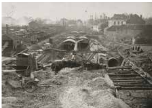
▲ De twee centrale openingen zijn bedoeld voor de doorstroming van de Zenne. Aan de rechterzijde zien we, gescheiden door een muur, de riolencollector, die gelijktijdig wordt aangelegd – ASB, s.d., fototheek, F48
