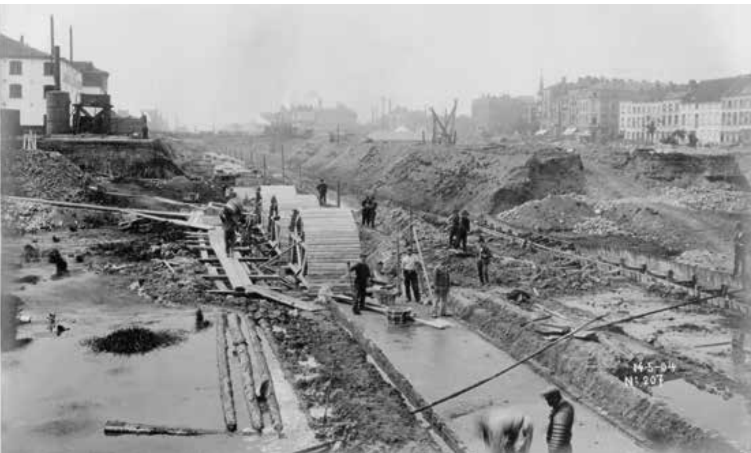
▲ Bouwwerkzaamheden aan de Haven van Brussel en de twee eerste secties van het zeekanaal door de Naamloze Vennootschap Zeekanaal en Haveninrichtingen van Brussel, 1904 – ASB, fototheek, J-735
