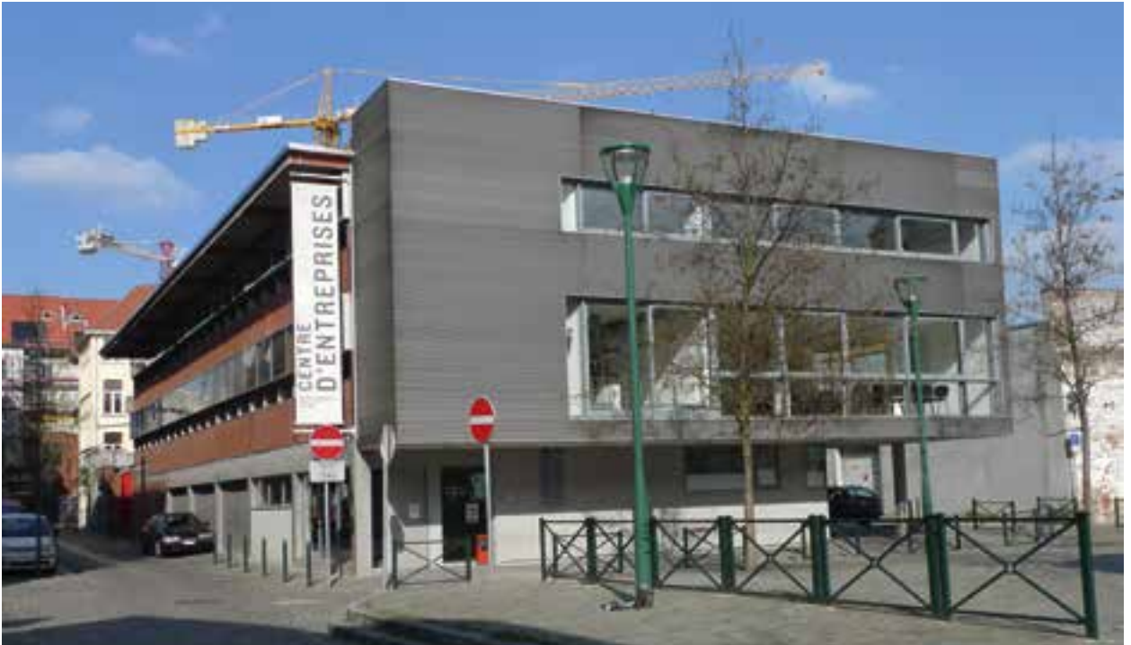
▲ Eén van de Molenbeekse bedrijventra, gelegen aan het Maalderijplein, richt zich tot zelfstandigen, KMO's en bedrijven die ondersteuning wensen op economisch of commercieel vlak.
