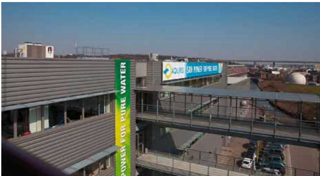
▲ Zuiveringsstation van Aquiris in Brussel-Noord
