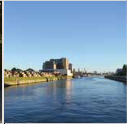
▼ Kanaaldijk richting Van Praetbrug
