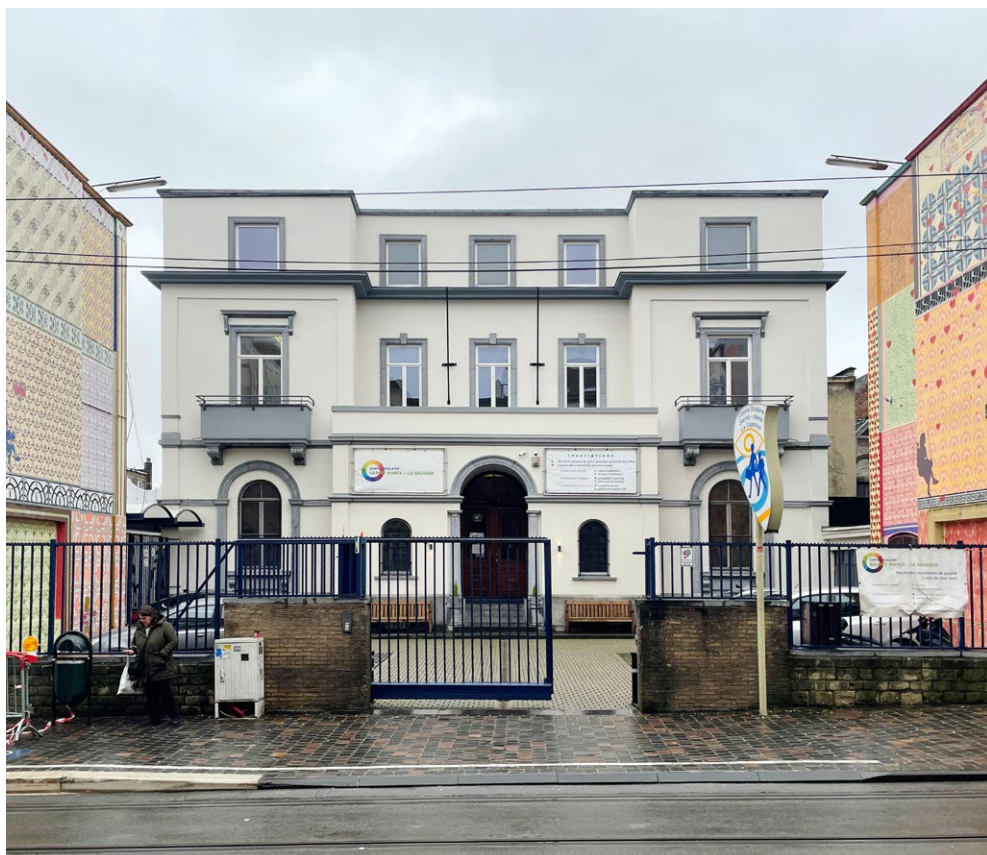
↑ Façade de l'école côté chaussée de Haecht, 2024 Schoolgevel aan de Haachtssteenweg, 2024
