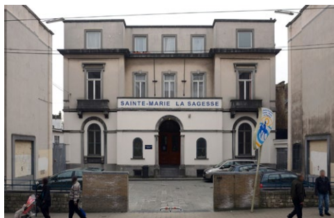
↑ Entrée côté chaussée de Haecht, cour d'honneur, 2013 | Source : Monument.heritage.brussels Schooltoegang via de Haachtssteenweg, binnenplein, 2013 | Bron: Monument.heritage.brussels
