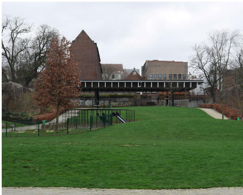
↑ Façade sud de l'école vue à partir du Parc Rasquinet Zuidgevel van de school gezien vanaf het Rasquinetpark
