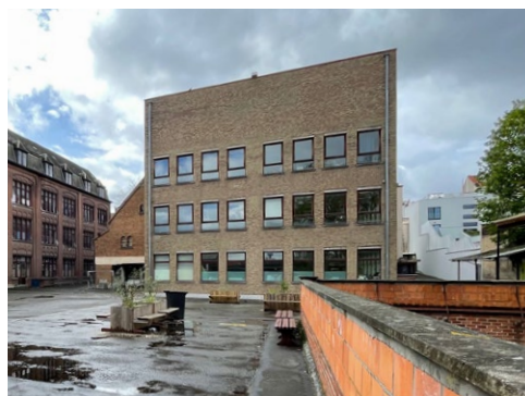
↑ Bâtiment B3 Gebouw B3
