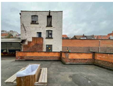
↑ Bâtiment D - aile Concorde Gebouw D - Concorde-vleugel
