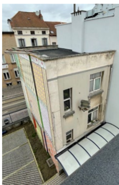
↑ Bâtiment A1 & A2 Gebouw A1 & A2
